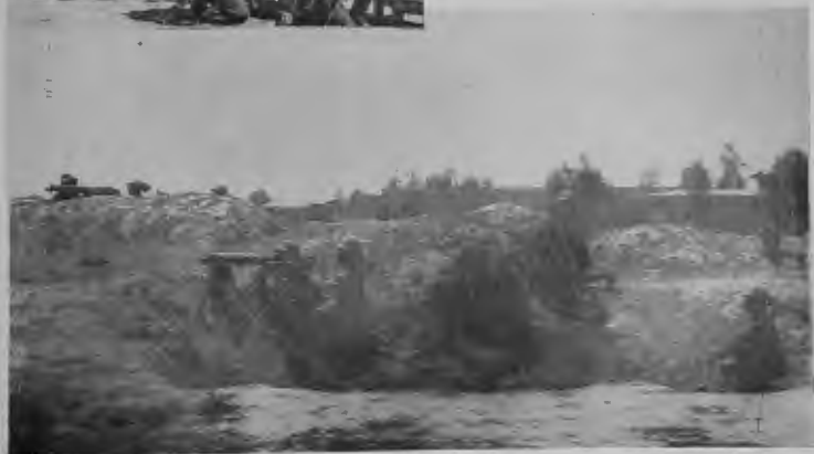
حفاثر رشاشات في الموضع Machine-Gun Section brought into action.
